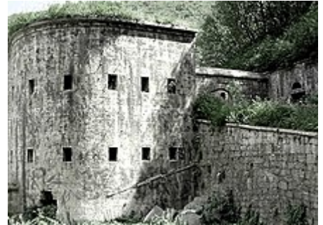
La tagliata stradale Bus de Vela , presso Cadine , poco sopra a Trento.
