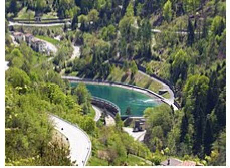
Il bacino artificiale di Stedileri, parte del complesso di sfruttamento idroelettrico del torrente Leno di Terragnolo
