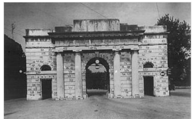
Porta Pradella prima della demolizione
