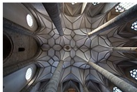
La volta stellare della Chiesa dei Francescani.
