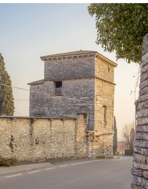
Torre Colombaia nella località di Prun
