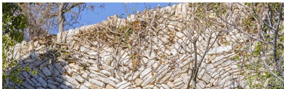
Particolare di muretto "a secco" (marogna)
