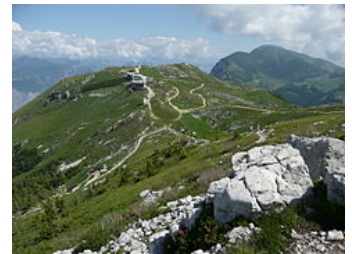
Vista della stazione di arrivo della Funivia da Malcesine
