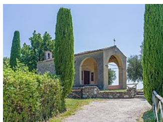
Chiesa di San Giorgio a Solarolo
