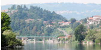
La diga di Sarnico
