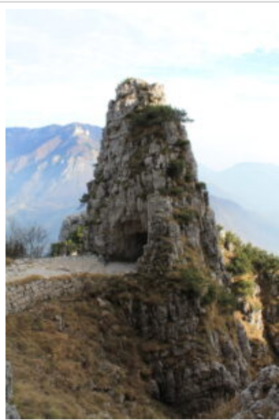
Uscita della 19a galleria
