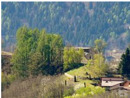
Il forte visto dal forte Col de le Bene
