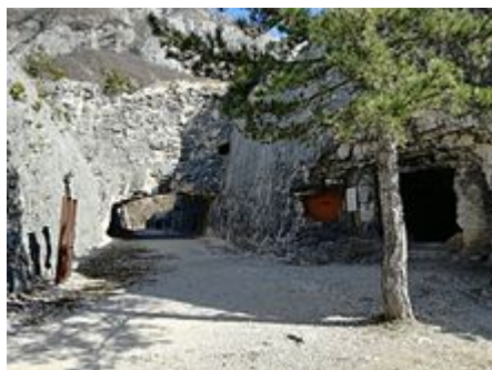
Il fossato di gola con il cosiddetto ponte dopo il restauro
