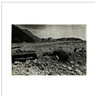
I resti del cantiere nel maggio 1916
