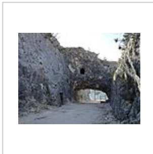
Il fossato di gola con il ponte vista valle
