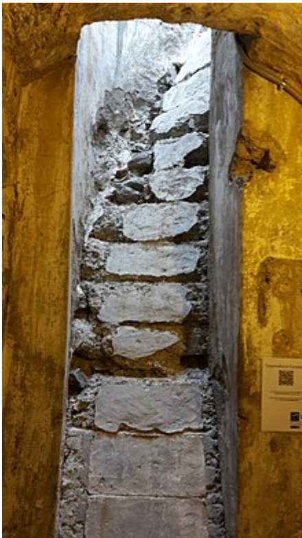
Accesso alla torretta
