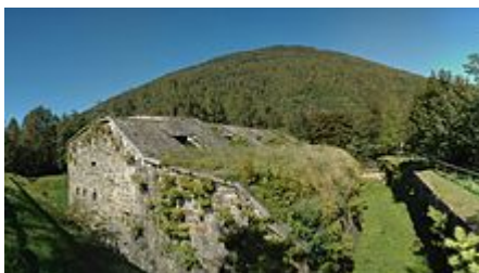
Il forte prima del restauro
