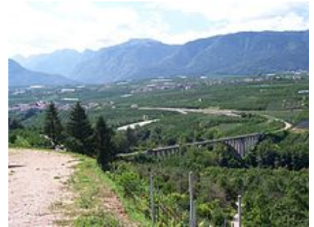
Ponte della ferrovia Trento-Malé-Mezzana sul Noce
