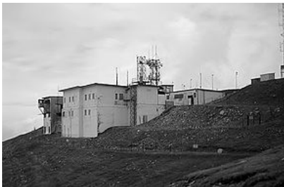
La base operativa del 16° Centro Radar A.M. dell'Aeronautica Militare sulla Plose
