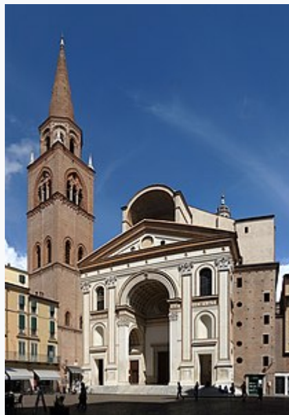
Basilica di Sant'Andrea dopo il restauro del 2016
