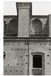
Particolari della facciata laterale. Foto di Paolo Monti
