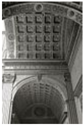
Particolari degli archi della facciata principale. Foto di Paolo Monti
