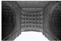
Particolari degli archi della facciata laterale. Foto di Paolo Monti
