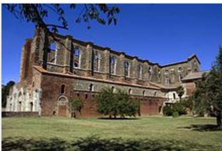
L'abbazia vista dal lato destro
