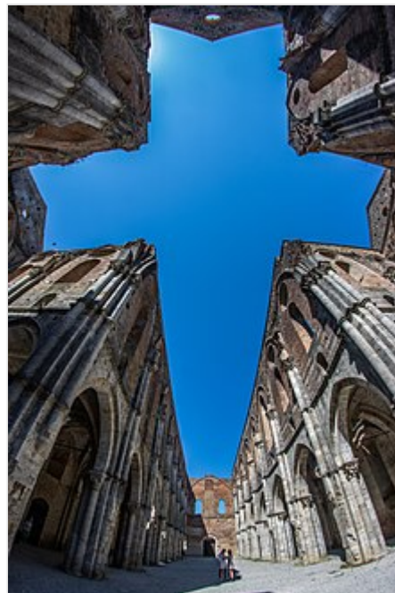
L'interno dell'abbazia di San Galgano
