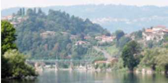
La diga di Sarnico
